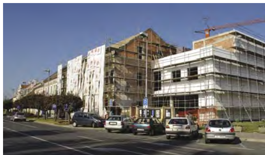
Radovi na zgradi u Glavnoj 35
