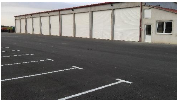
Sl. 16. Garaže u reciklažnom dvorištu
