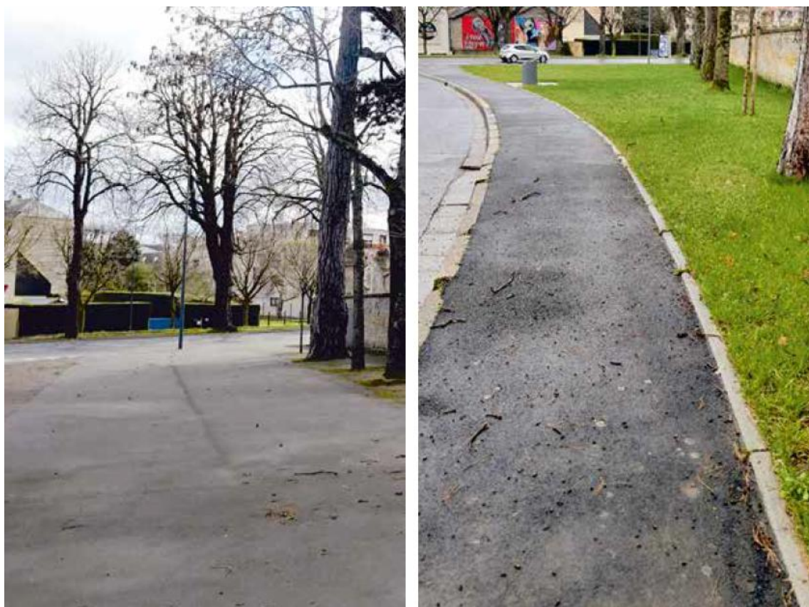
Slika 113 Uklanjanje dijela asfalta u ulici Eugènea Boudina (Izvor: Ville de Caen)
