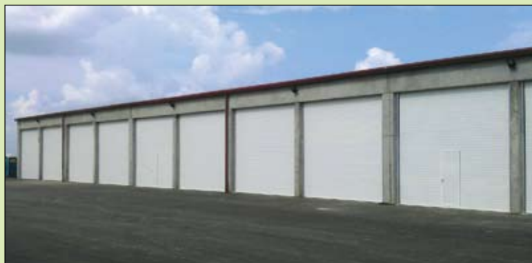
Reciklažno dvorište, sortirnica i garaže PRE-KOM-a
